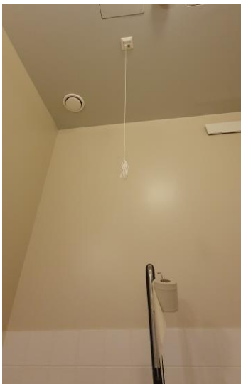
Kuva, esteetön WC
